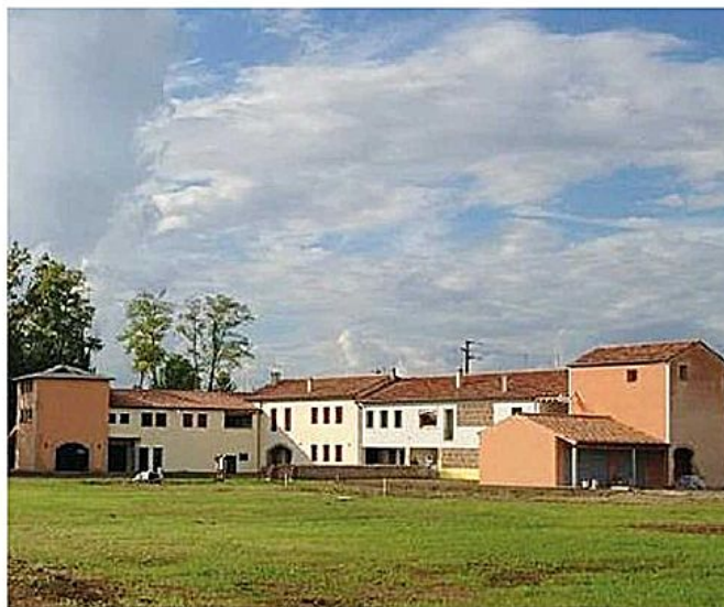
Borgo Torri sulla Lia, l'ultimo cantiere di Stefano Da Fies
