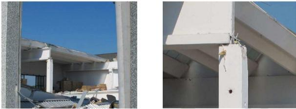
Terremoto Emilia Romagna 2012. Molte zone "non sismiche", con la mappatura INGV, sono diventate "sismiche". In alcuni edifici industriali relativamente recenti (luoghi di lavoro), sono state riscontrate carenze probabilmente dovute al fatto che il calcolo era stato originariamente condotto non considerando gli effetti che avrebbe potuto provocare un terremoto.
